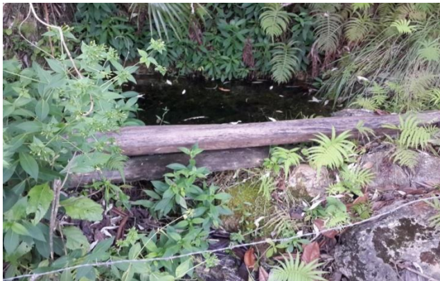
Ilustración 4, pozo construido por Subirana según informaron los habitantes. Se le conoce como el Pozo de la Misión
